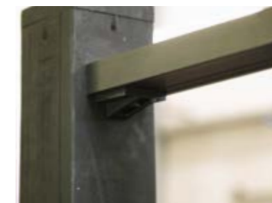
FIXATION MAIN COURANTE SEULE MURALE SIMPLE
