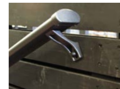
FIXATION MAIN COURANTE SEULE SUR ÉCUYER
