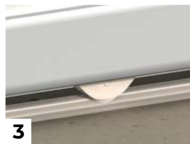
3 Roulette et rail au sol inox
